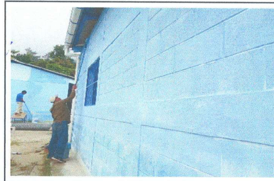
Foto 4: panorama de reparación o sustitución de área de cocina
