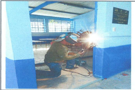
Foto 3: panorama de reparación de puertas
