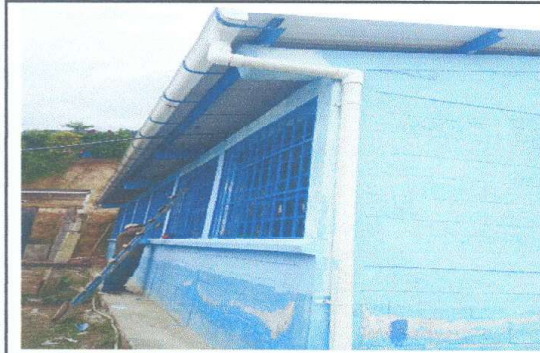
Foto 3: panorama del edificio escolar pintura interior y exterior
