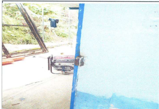
Foto 2: panorama de reparación de puertas
