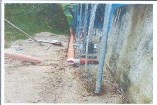
Foto 1: panorama de mejoramiento de agua potable
