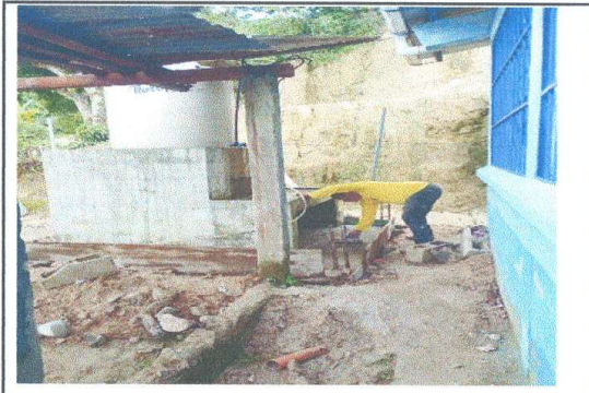
Foto 2: panorama de mejoramiento de agua potable
