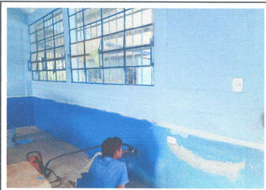
Foto 2: panorama del edificio escolar pintura interior y exterior
