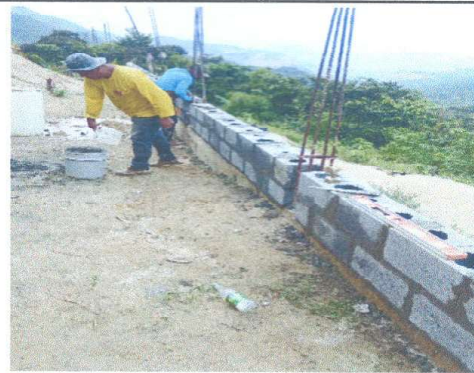
Foto 2: panorama de muro
