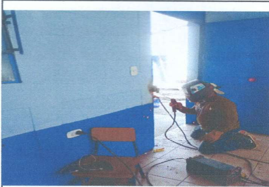
Foto 1: panorama de reparación de puertas
