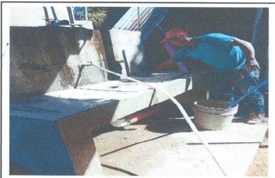
Foto 4: panorama de mejoramiento de agua potable
